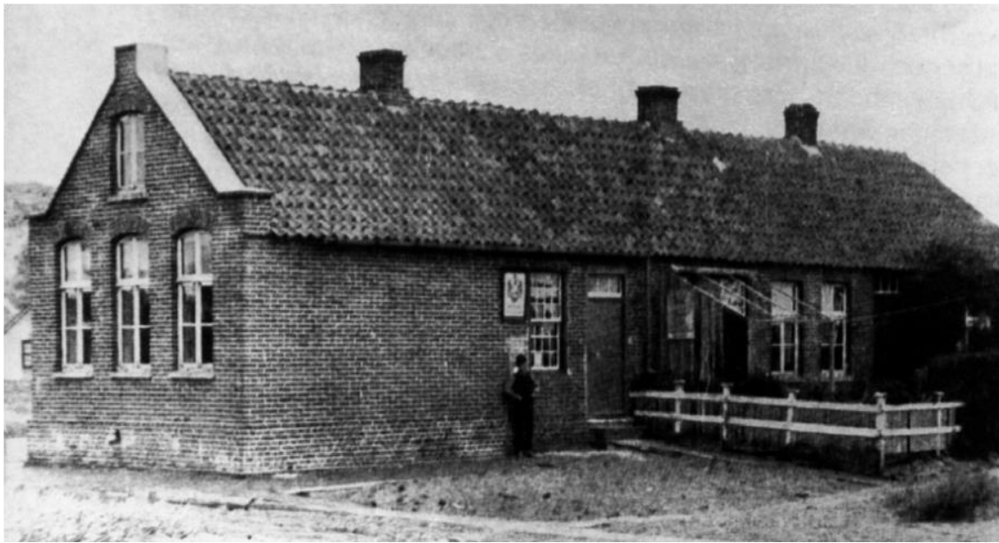
Schule um 1880. Links Klassenraum, rechts Poststation und Lehrerwohnung
